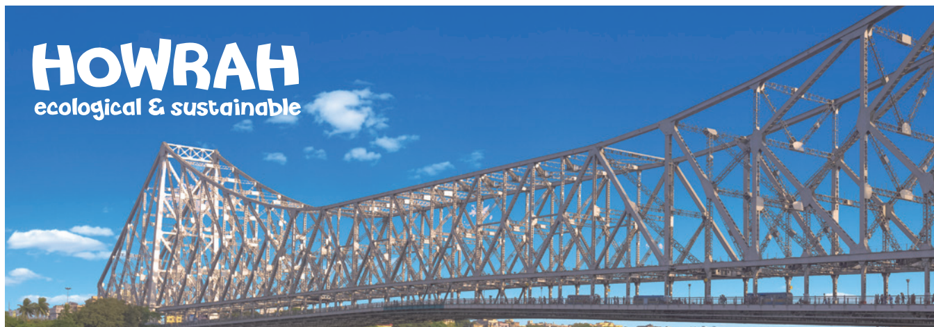
ーインド・コルカタ HOWRAH ブリッジー ハウラー
